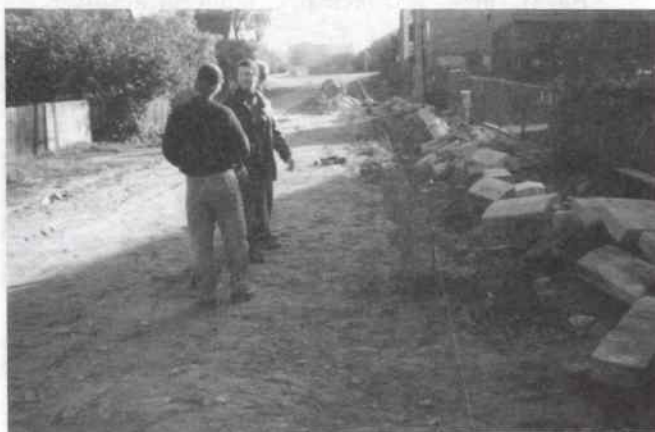
Przygotowania do budowy drogi na ulicy Reymonta
