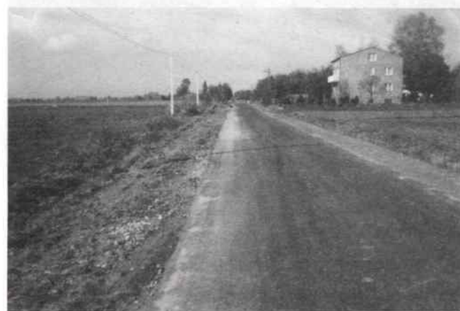
Bugaj Nowy - nowa droga
