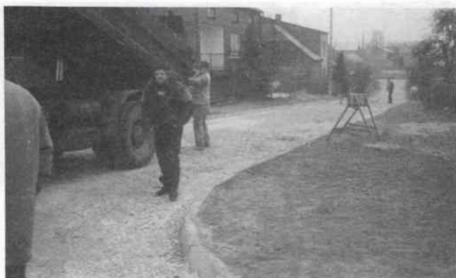
Budowa drogi na ulicy Dworskiej w Rudnikach
