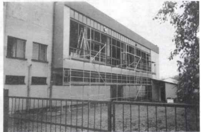
Remont w GOKSiR
