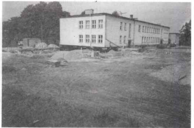
Prace przy budowie Gimnazjum w Rudnikach - październik 2002 r.
