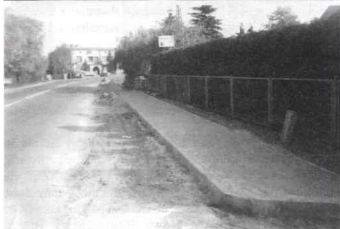
Budowa chodnika w Jaworznie
