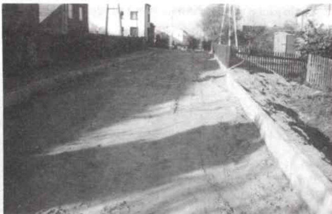
Budowa ulicy Reymonta
