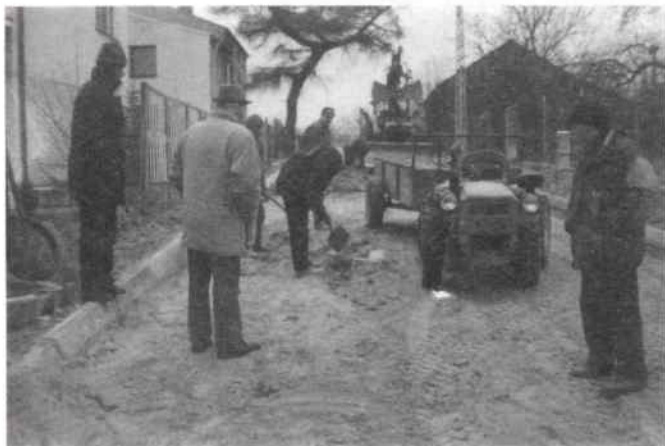
Budowa drogi w Rudnikach
