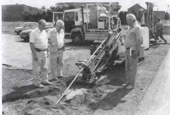
Budowa kanalizacji w Jaworznie
