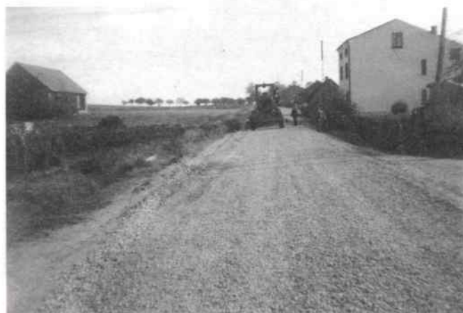
Bugaj Nowy - w trakcie prac modernizacyjnych
