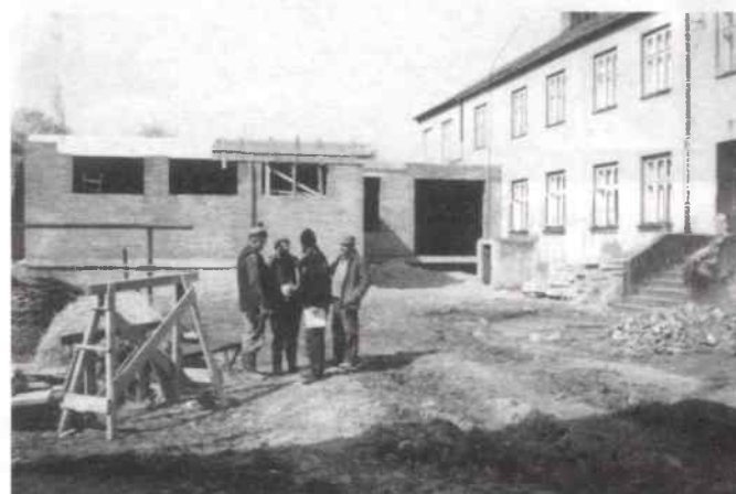
Prace remontowo-budowlane w Szkole Podstawowej w Dalachowie
