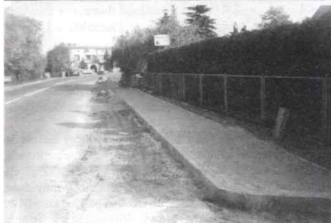
Budowa chodnika w Jaworznie
