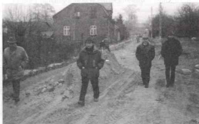
Przygotowanie podłoża pod asfalt na ulicy Sienkiewicza w Rudnikach
