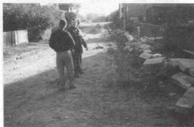
Przygotowania do budowy drogi na ulicy Reymonta
