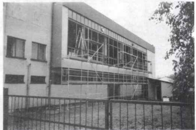
Remont w GOKSiR
