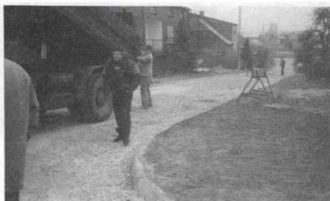
Budowa drogi na ulicy Dworskiej w Rudnikach
