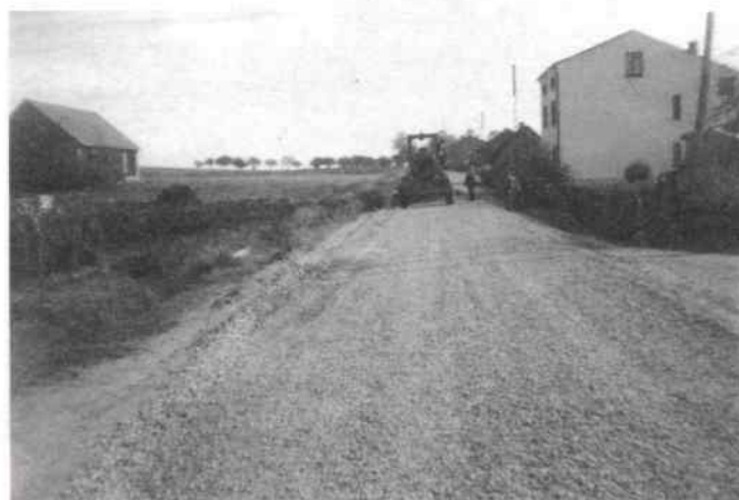
Bugaj Nowy - w trakcie prac modernizacyjnych
