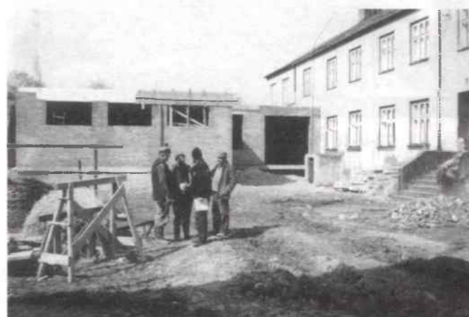
Prace remontowo-budowlane w Szkole Podstawowej w Dalachowie
