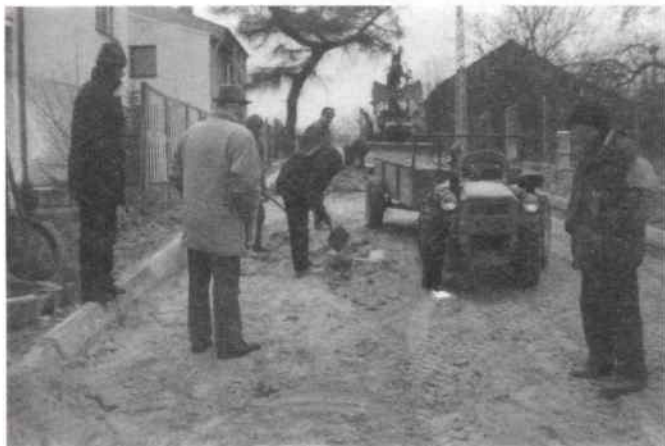
Budowa drogi w Rudnikach
