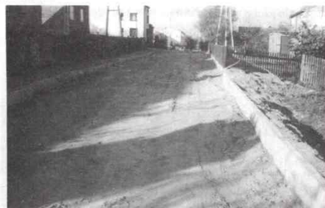
Budowa ulicy Reymonta
