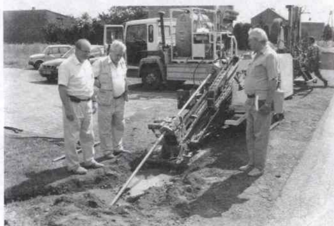
Budowa kanalizacji w Jaworznie
